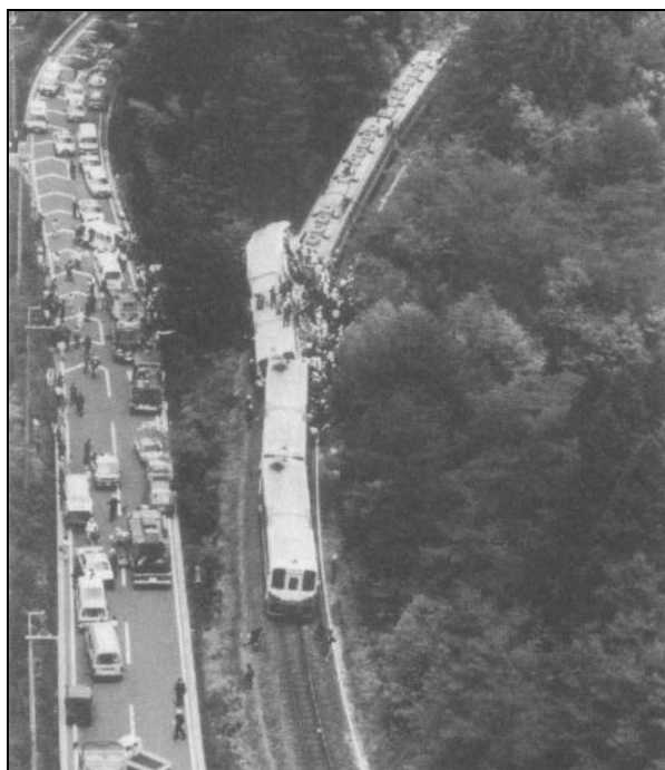
図 15：列車衝突事故写真(信楽方より撮影)
